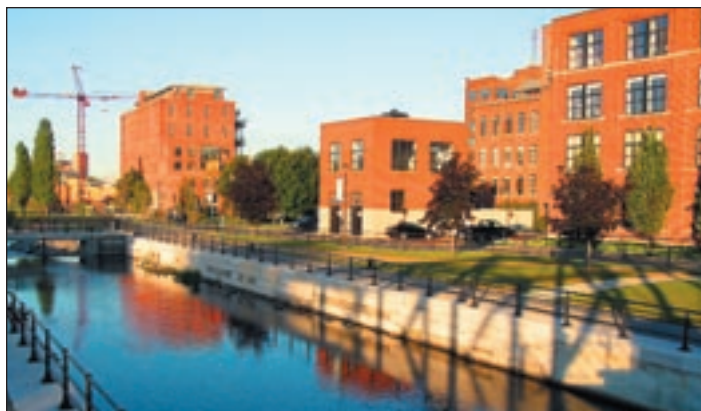
Vue d'ensemble vers l'est des écluses Saint-Gabriel et de l'ancienne RedPath.
